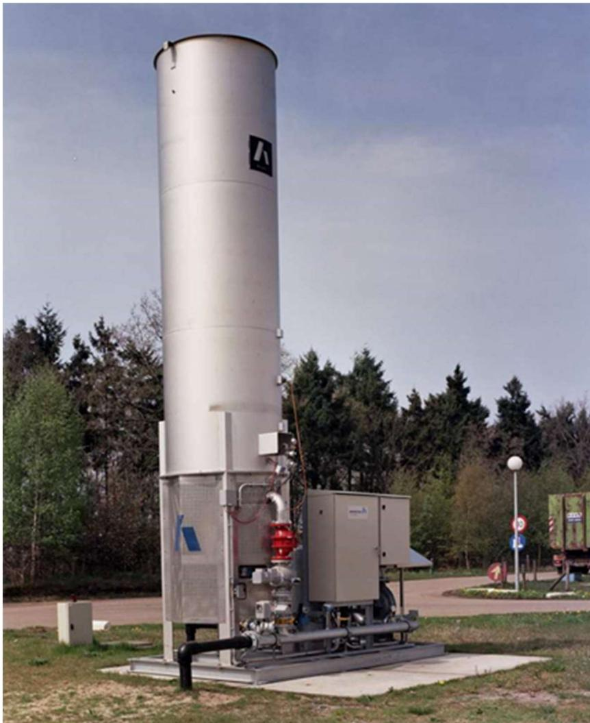
**Рисунок 5 – Газосжигательная установка.**
